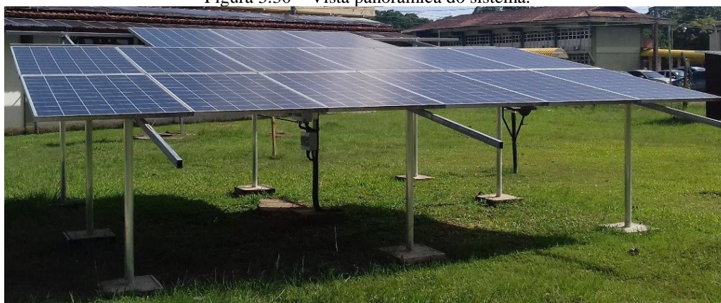
Figura 3.30 – Vista panorâmica do sistema.
