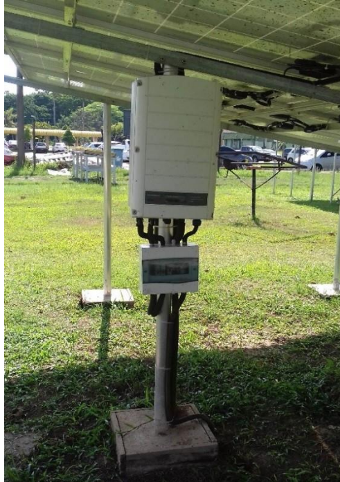
Figura 3.31 – Inversor e quadro de disjuntores.
