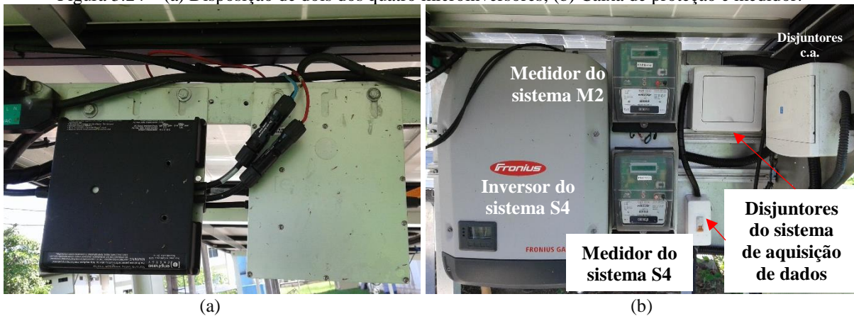
Figura 3.24 – (a) Disposição de dois dos quatro microinversores; (b) Caixa de proteção e medidor.
