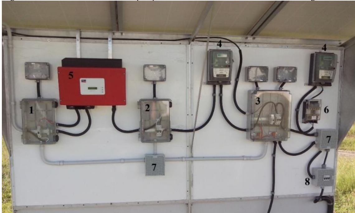
Figura 3.12 – Painel demonstrativo de operação do sistema instalado na mesma estrutura do gerador FV.
