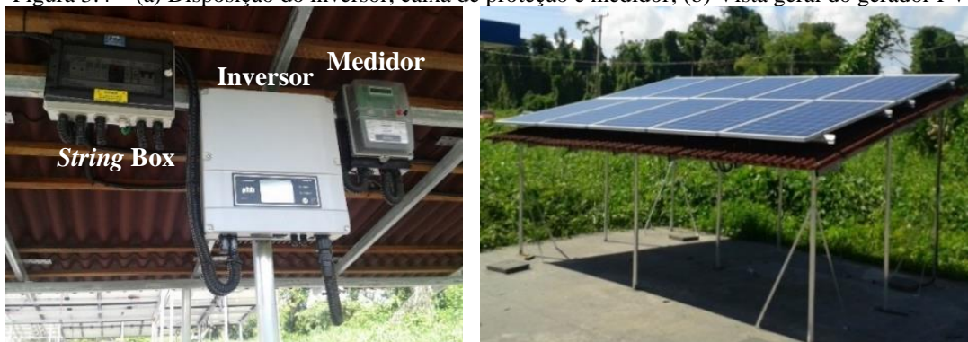
Figura 3.4 – (a) Disposição do inversor, caixa de proteção e medidor; (b) Vista geral do gerador FV.
