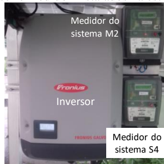
Figura 3.18 – Inversor e medidor instalados na estrutura do sistema M1.
