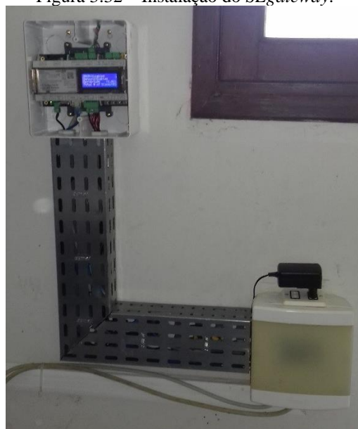
Figura 3.32 – Instalação do SEgateway .
