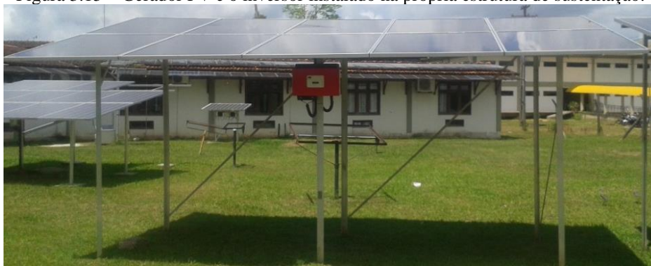
Figura 3.15 – Gerador FV e o inversor instalado na própria estrutura de sustentação.
