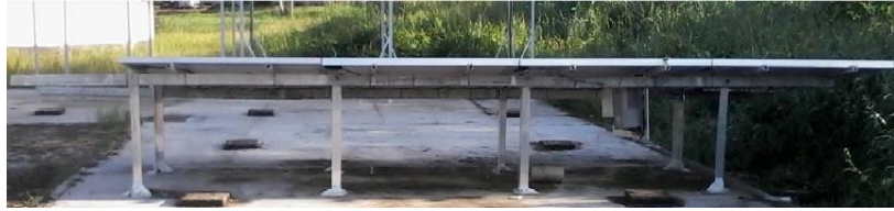
Figura 3.17 – Estrutura do gerador FV.
